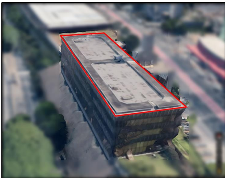
Figura 20 - Área destinada à instalação do sistema fotovoltaico
