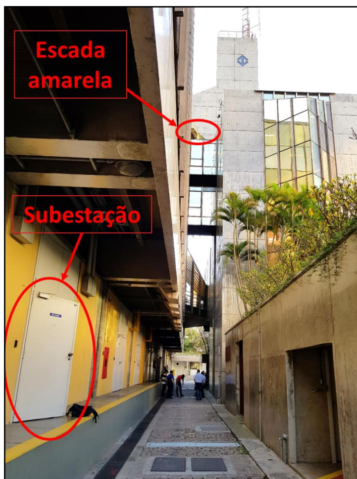
Figura 30 - Subestação da edificação
