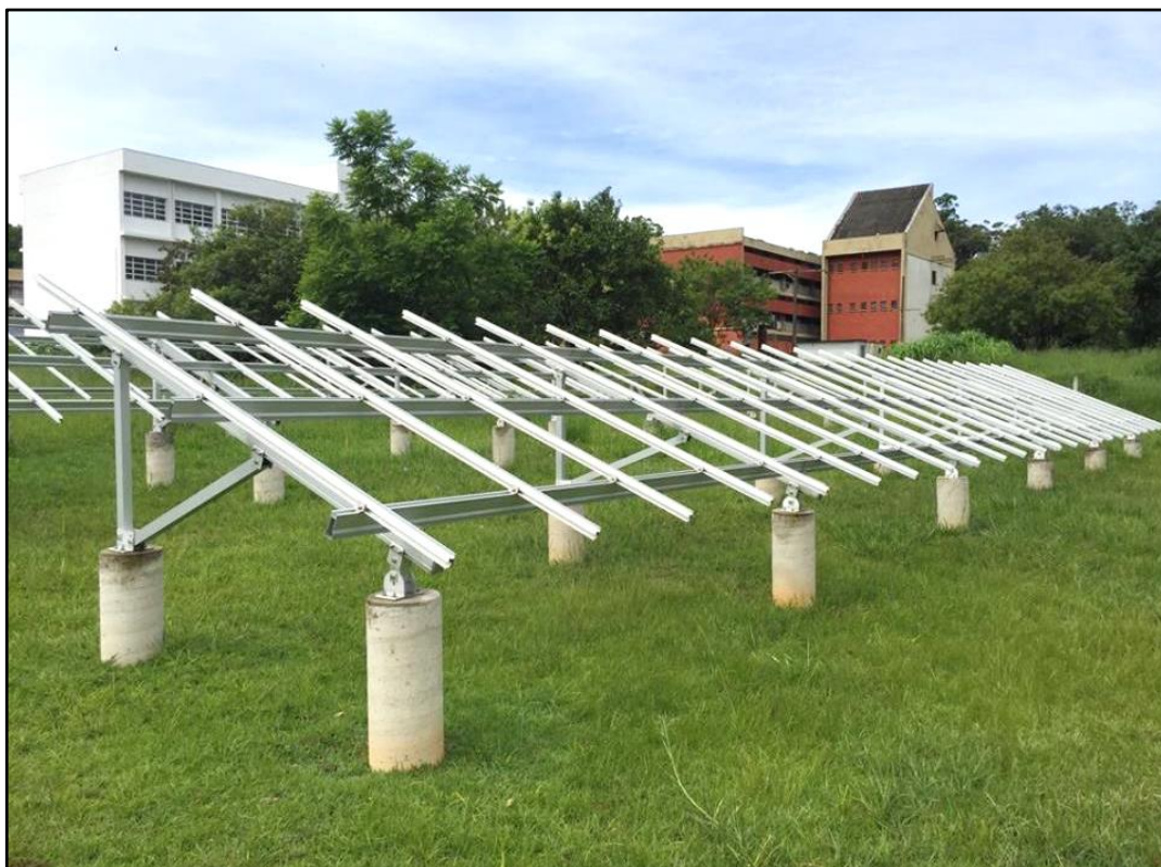
Figura 8 - Exemplo de estrutura de suporte para módulos fotovoltaicos
