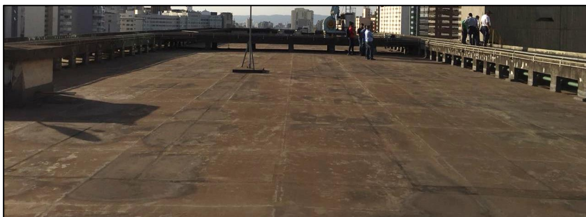
Figura 29 - Cobertura da edificação
