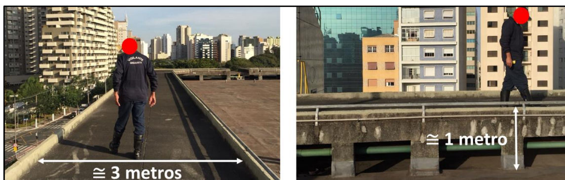
Figura 25 - Estrutura de alvenaria entorno das áreas úteis
