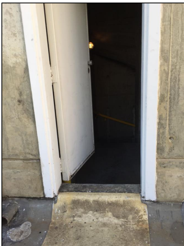
Figura 26 - Porta para acesso à cobertura
